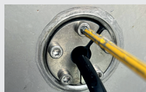
Serrage de l'élément Press & Close
