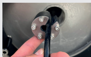
Mise en place de l'élément Press & Close après le tirage
