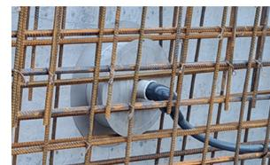
Grazie al sistema Press & Close, il cavo elettrico non deve più passare sopra la linea di galleggiamento. In questo modo è più facile inserire e tirare i cavi.
