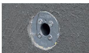
5. Éléments de base étanchéifiés au liner liquide
