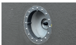
4. Étanchéité au liner liquide
