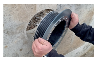
3. Insérer l'élément de base dans le perçage
