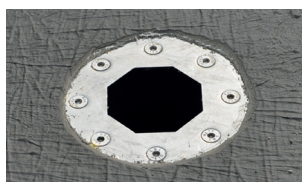
6. Éléments de base étanchéifiés au liner liquide
