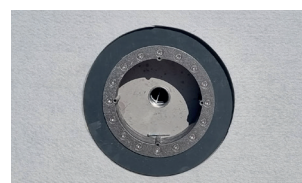
4. Éléments de base posés et prêts pour la pose du liner
