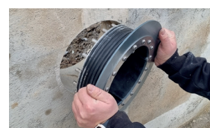
3. Inserire l'elemento base nel foro
