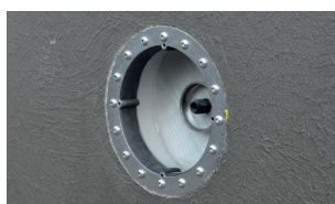
4. Sigillato con liner liquido
