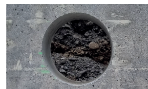
1. Foro di carotaggio \varnothing 250 mm
