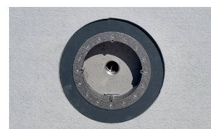
4. Elemento di base applicato e pronto per la posa del liner
