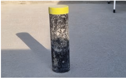
1. Tube PE scellé dans la dalle
