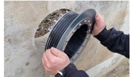
3. Insérer l'élément de base dans le perçage
