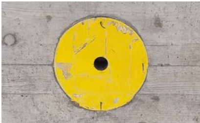
4. Corps à encastrer avec protection de coffrage bétonnée
