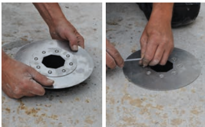
5. Mettre l'élément de base en place et serrer avec une clé
