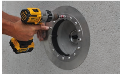
3. Serrer l'élément de base, ne le monter qu'après reprofilage des murs
