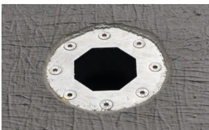
6. Bonde de fond étanchéifiée au liner liquide
