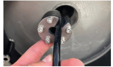
2. Mettre le joint de câble Press & Close en place après avoir tiré le câble
