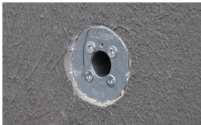
5. Élément de base étanchéifié au liner liquide
