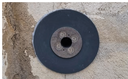
Montage de l'élément de base directement dans le carottage
