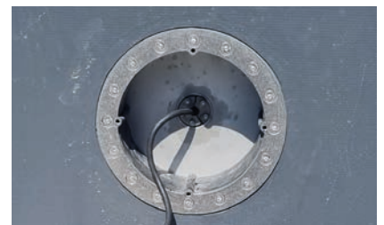
5. Câble tiré et étanchéifié avec le système Press & Close
