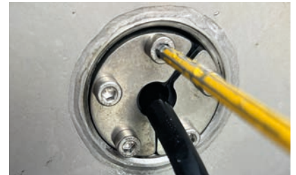
3. Serrer le joint de câble Press & Close à la main ou avec une visseuse sans fil
