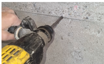
1. Percer un trou pour la douille taraudée de la flasque de montage
