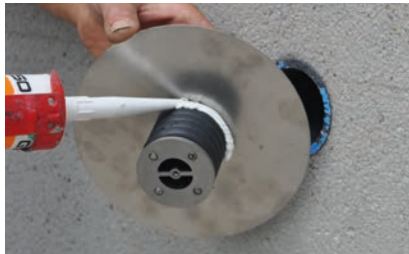
3. Monter l'élément de base, si nécessaire appliquer un peu de colle supplémentaire
