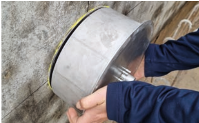
3. Serrer le corps à encastrer jusqu'à la butée
