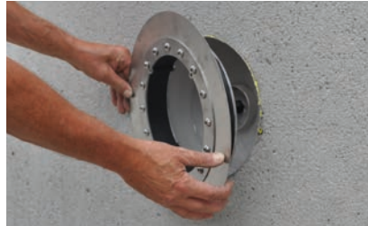
2. Poser et aligner l'élément de base
