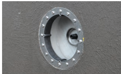
4. Étanchéité au liner liquide
