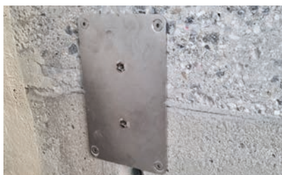
5. Flasque de montage entièrement montée
