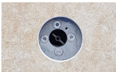
6. Revêtu d'un carrelage en grès cérame
