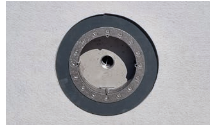
4. Élément de base posé et prêt pour la pose du liner
