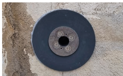
Montaggio dell'elemento base direttamente nel foro di carotaggio
