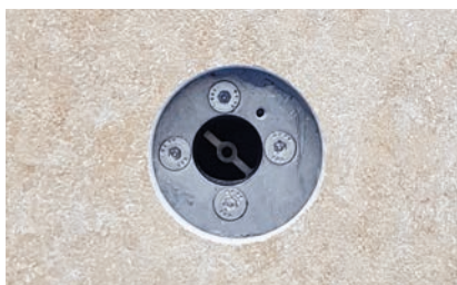
6. Rivestimento con piastrelle in gres porcellanato
