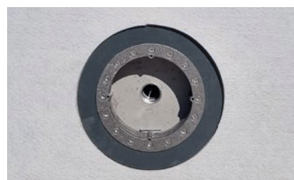
4. Elemento base applicato e pronto per la posa del liner
