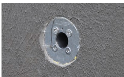
5. Elemento base sigillato con liner liquido
