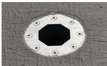
6. Scarico a pavimento sigillato con liner liquido
