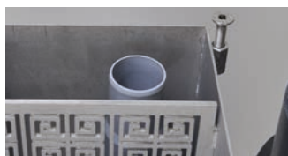
Il collare dello skimmer è necessario per sigillare con sigillante liquido l'area intorno all'apertura di ispezione.
