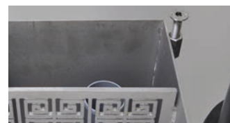
Il collare dello skimmer è necessario per sigillare con sigillante liquido l'area intorno all'apertura di ispezione.
