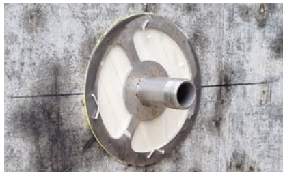
1. Inchioidare la protezione della cassaforma alla cassaforma
