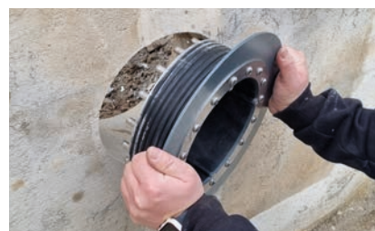
3. Inserire l'elemento base nel foro
