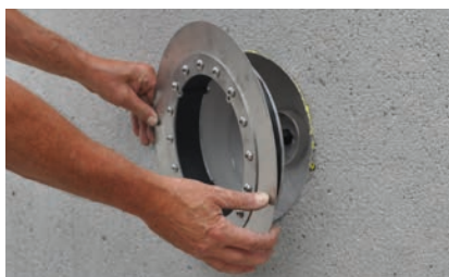
2. Applicare ed allineare l'elemento base
