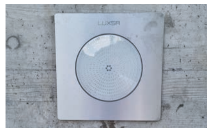
6. Installazione del faro ultimata
