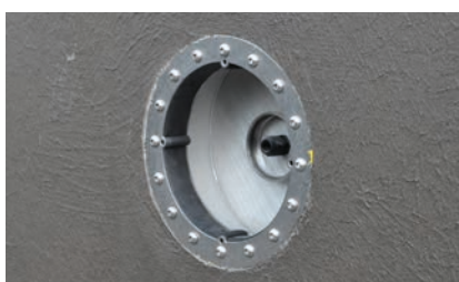
4. Sigillato con liner liquido
