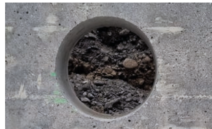
1. Foro di carotaggio \varnothing 250 mm
