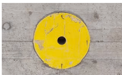
4. Involucro con protezione della cassaforma inserito nel calcestruzzo
