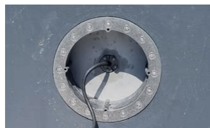
5. Il cavo viene tirato e sigillato con il sistema Press & Close.
