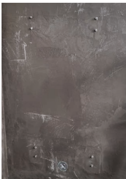
8. L'impermeabilizzazione è stata applicata
