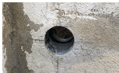
Foro di carotaggio \varnothing 70 mm
