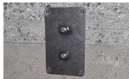
6. Avvitare le viti per proteggere i fori ciechi.
