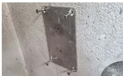
4. Montare la flangia di montaggio con viti e tasselli
