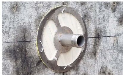
1. Inchiudere la protezione della cassaforma alla cassaforma
