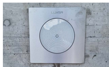
6. Installazione del faro ultimata
