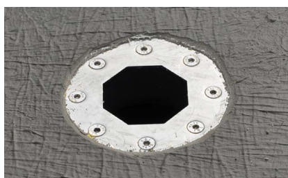
6. Scarico di fondo sigillato con liner liquido
