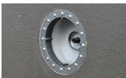
4. Sigillato con liner liquido
