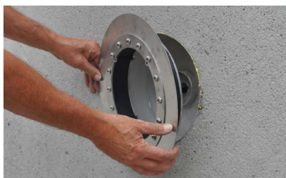
2. Applicare ed allineare l'elemento base
