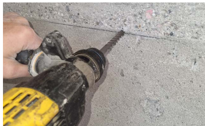
1. Praticare un foro per il manicotto filettato della flangia di montaggio.
