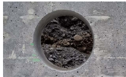
1. Foro di carotaggio \varnothing 250 mm
