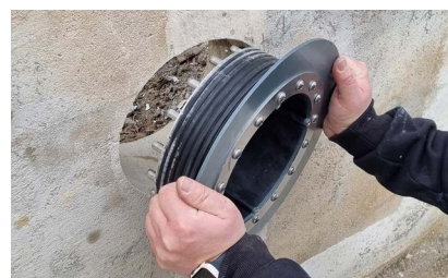
3. Inserire l'elemento base nel foro
