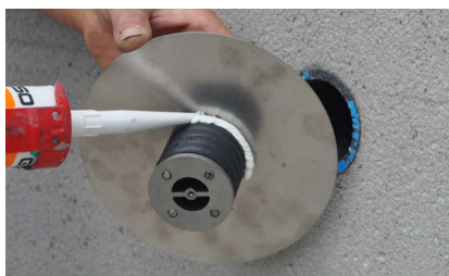
3. Montare l'elemento base, applicando, se necessario, ulteriore adesivo
