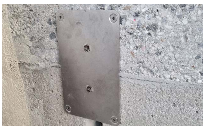
5. Flangia di montaggio completamente montata
