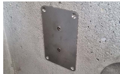
3. È possibile applicare la flangia di montaggio e praticare i fori per il fissaggio.
