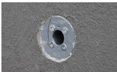
5. Elemento base sigillato con liner liquido
