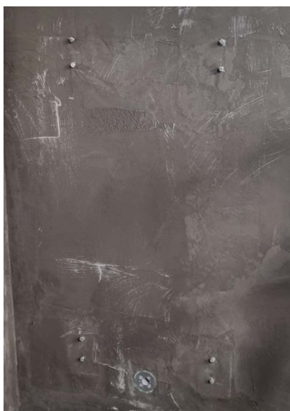
8. L'impermeabilizzazione è stata applicata
