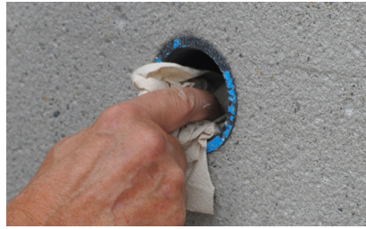
2. Gewinde reinigen
