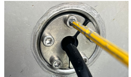
3. Press & Close-Kabeldichtung von Hand oder mit Akku-Schrauber anziehen
