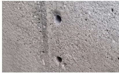
2. Gebohrte Löcher \varnothing 12 mm
