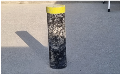
1. PE-Rohr eingelegt in Bodenplatte
