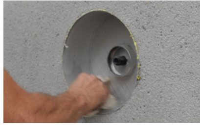
1. Gehäuse reinigen
