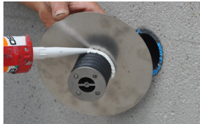
3. Grundelement montieren ggf. zusätzlich Klebmasse anbringen
