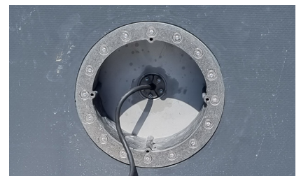
5. Kabel eingezogen und mit Press & Close-System abgedichtet
