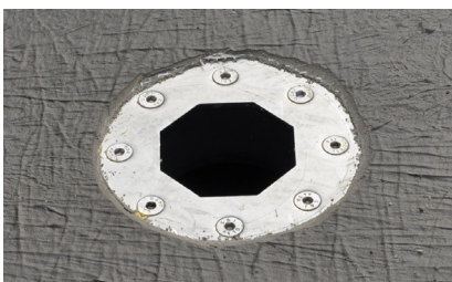
6. Bodenablauf mit Flüssigfolie abgedichtet
