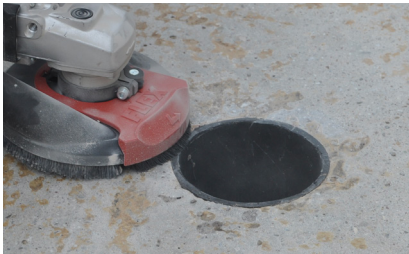
3. Leichtes Gefälle schleifen
