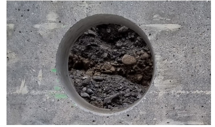
1. Kernbohrung \varnothing 250 mm
