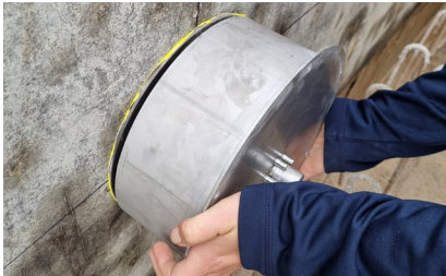
3. Einbaugehäuse bis Anschlag anziehen
