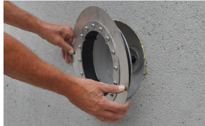
2. Grundelement setzen und ausrichten
