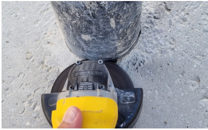
2. Rohr abschneiden
