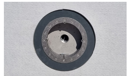
4. Grundelement gesetzt und bereit für Folienverlegung
