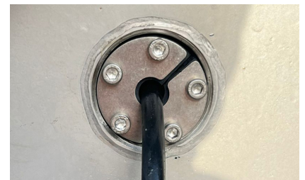
4. Kabeldurchführung 100% wasserdicht
