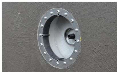
4. Abgedichtet mit Flüssigfolie
