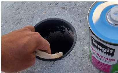
4. Rohr reinigen
