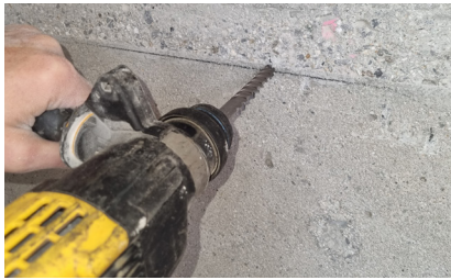
1. Loch bohren für Gewindehülse des Montageflansches
