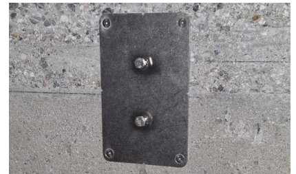
6. Zum Schutz der Sacklöcher Schraube eindrehen
