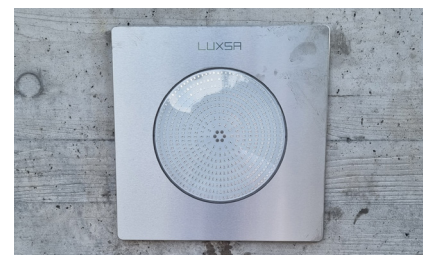
6. Fertig installierter Scheinwerfer
