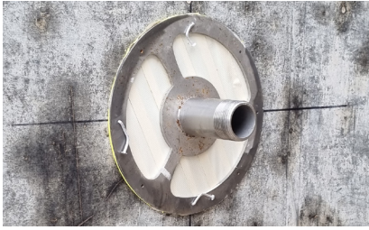
1. Schalungsschoner an Schalung nageln
