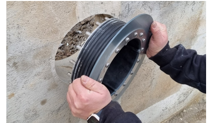
3. Grundelement einsetzen in Bohrung
