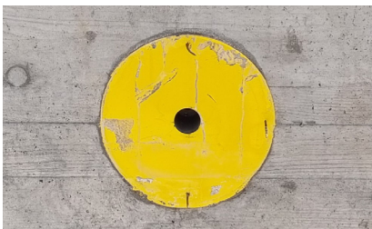
4. Einbaugehäuse mit Schalungsschoner einbetoniert
