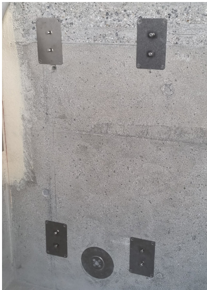
7. Montageflansche für eine Leiter
