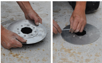
5. Grundelement setzen und mit Schlüssel anziehen
