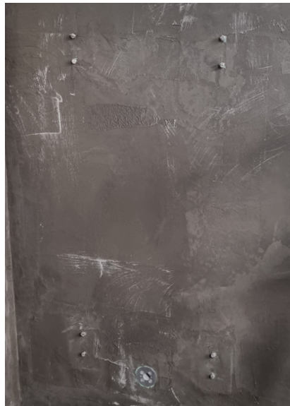
8. Abdichtung wurde aufgetragen
