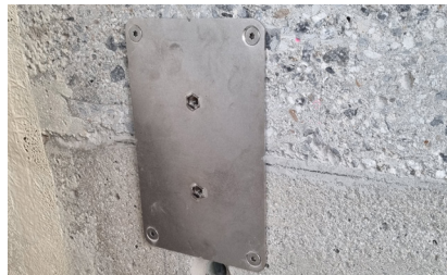
5. Fertig montierter Montageflansch
