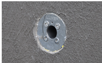
5. Grundelement mit Flüssigfolie abgedichtet
