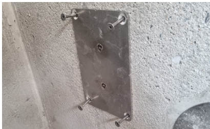
4. Montageflansch mit Schrauben und Dübel montieren
