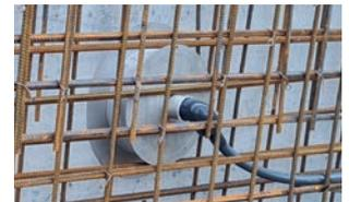
Dank des Press & Close-Systems muss die Elektroleitung nicht mehr über die Wasserlinie führen. Dies erleichtert die Einlegearbeiten sowie den Kabeleinzug.
