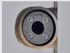
Düsengrundelement montiert im defekten Gewinde
