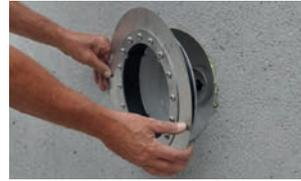
2. Grundelement setzen und ausrichten
