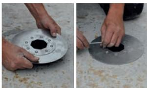
5. Grundelement setzen und mit Schlüssel anziehen
