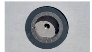
4. Grundelement gesetzt und bereit für Folienverlegung
