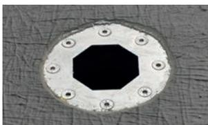
6. Grundelemente abgedichtet mit Flüssigfolie
