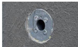
5. Grundelement mit Flüssigfolie abgedichtet
