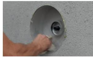
1. Gehäuse reinigen
