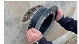
3. Grundelement einsetzen in Bohrung
