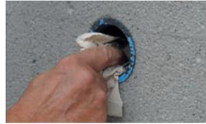
2. Gewinde reinigen
