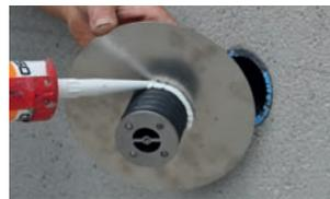
3. Grundelement montieren ggf. zusätzlich Klebmasse anbringen
