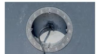
5. Kabel eingezogen und mit Press & Close-System abgedichtet
