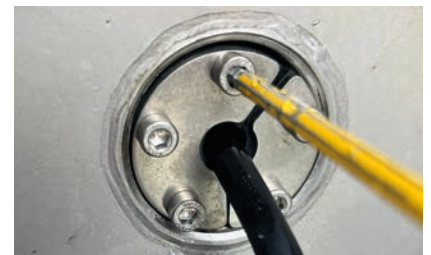
3. Press & Close-Kabeldichtung von Hand oder mit Akku-Schrauber anziehen
