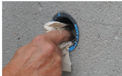
2. Gewinde reinigen
