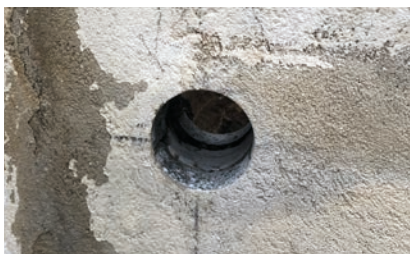
Kernbohrung \varnothing 70 mm
