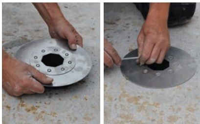
5. Grundelement setzen und mit Schlüssel anziehen
