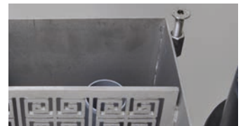
Der Skimmerkragen wird benötigt, um mit der Flüssigabdichtung auch im Bereich der Revisionsöffnung abzudichten.
