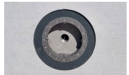
4. Grundelement gesetzt und bereit für Folienverlegung
