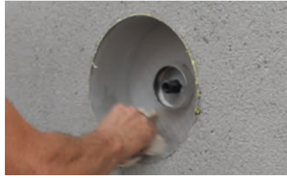
1. Gehäuse reinigen
