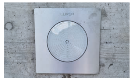
6. Fertig installierter Scheinwerfer
