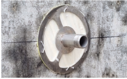
1. Schalungsschoner an Schalung nageln
