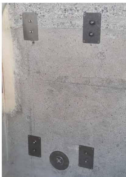
7. Montageflansche für eine Leiter
