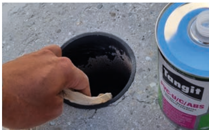
4. Rohr reinigen
