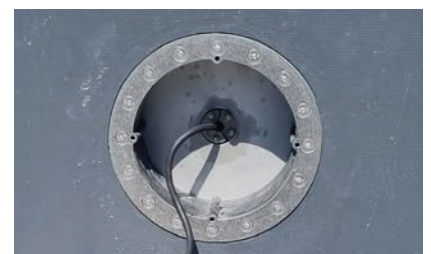
5. Kabel eingezogen und mit Press & Close-System abgedichtet
