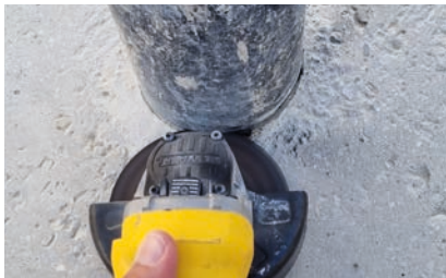
2. Rohr abschneiden
