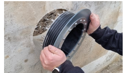
3. Grundelement einsetzen in Bohrung
