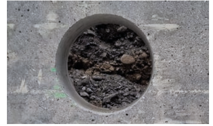
1. Kernbohrung \varnothing 250 mm
