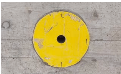
4. Einbaugehäuse mit Schalungsschoner einbetoniert
