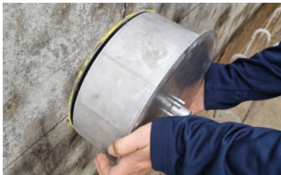
3. Einbaugehäuse bis Anschlag anziehen
