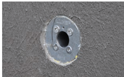
5. Grundelement mit Flüssigfolie abgedichtet
