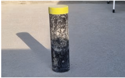
1. PE-Rohr eingelegt in Bodenplatte
