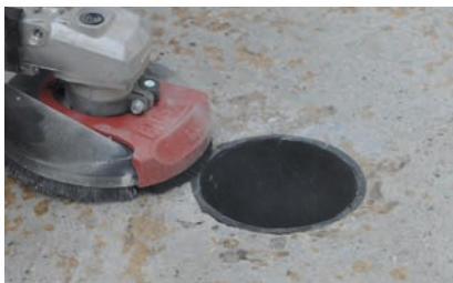
3. Leichtes Gefälle schleifen
