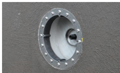
4. Abgedichtet mit Flüssigfolie
