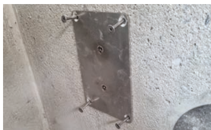
4. Montageflansch mit Schrauben und Dübeln montieren
