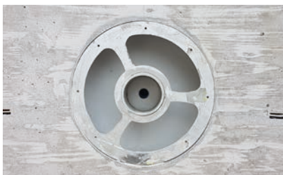
5. Schalungshilfe ausdrehen
