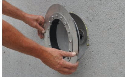
2. Grundelement setzen und ausrichten
