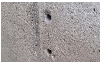
2. Gebohrte Löcher \varnothing 12 mm
