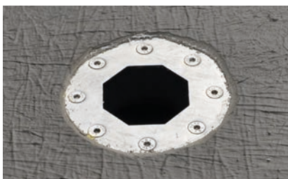
6. Bodenablauf mit Flüssigfolie abgedichtet
