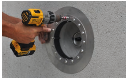
3. Grundelement anziehen, erst montieren, wenn Wände reprofiliert sind
