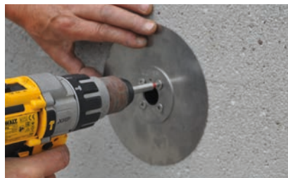
4. Grundelement anziehen
