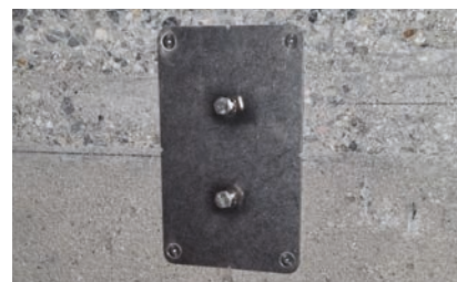
6. Zum Schutz der Sacklöcher Schraube eindrehen
