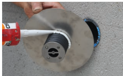
3. Grundelement montieren ggf. zusätzlich Klebmasse anbringen
