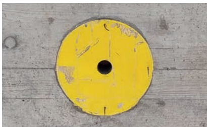
4. Einbaugehäuse mit Schalungsschoner einbetoniert
