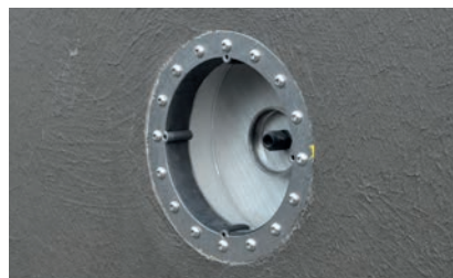
4. Abgedichtet mit Flüssigfolie
