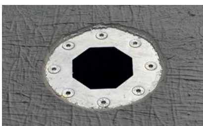
6. Bodenablauf mit Flüssigfolie abgedichtet
