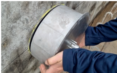
3. Einbaugehäuse bis Anschlag anziehen
