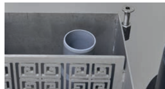
Der Skimmerkragen wird benötigt, um mit der Flüssigabdichtung auch im Bereich der Revisionsöffnung abzudichten.
