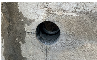
Kernbohrung \varnothing 70 mm
