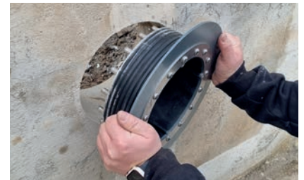
3. Grundelement einsetzen in Bohrung
