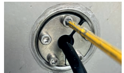
3. Press & Close-Kabdichtung von Hand oder mit Akku-Schrauber anziehen
