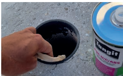
4. Rohr reinigen
