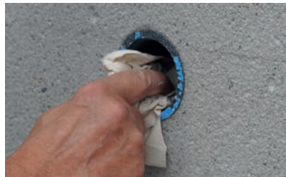
2. Gewinde reinigen
