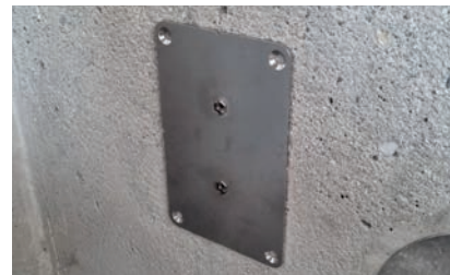
3. Montageflansch kann gesetzt werden, Löcher für Befestigung gebohrt
