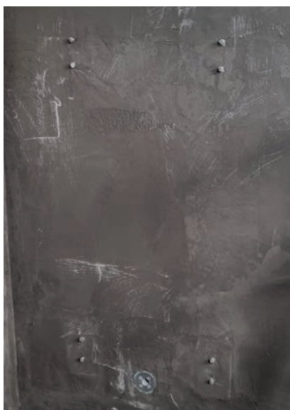
8. Abdichtung wurde aufgetragen
