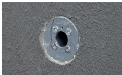
5. Grundelement mit Flüssigfolie abgedichtet
