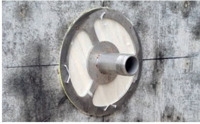
1. Schalungsschoner an Schalung nageln
