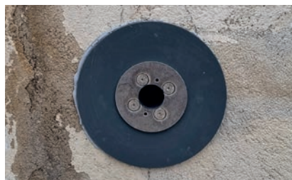
Montage des Grundelements direkt in Kernbohrung
