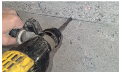
1. Loch bohren für Gewindehülse des Montageflansches
