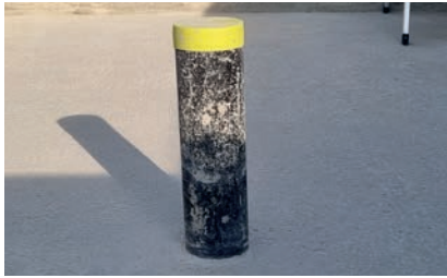
1. PE-Rohr eingelegt in Bodenplatte
