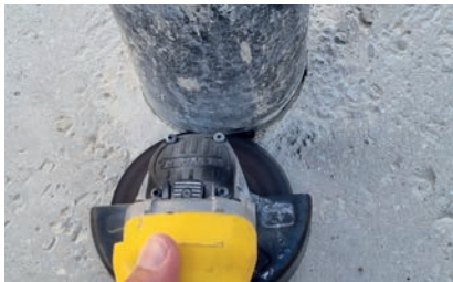
2. Rohr abschneiden
