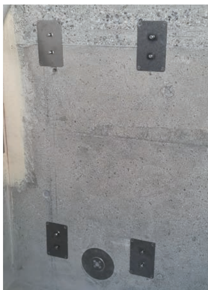
7. Montageflansche für eine Leiter
