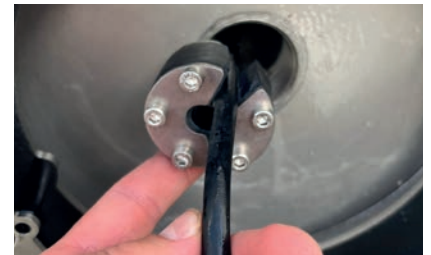
2. Setzen der Press & Close-Kabdichtung nach dem Einziehen des Kabels
