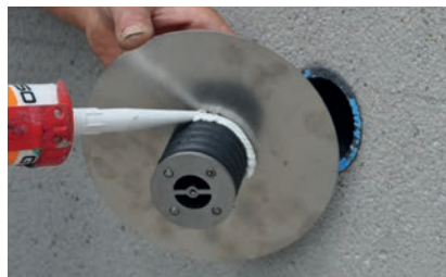
3. Grundelement montieren ggf. zusätzlich Klebmasse anbringen
