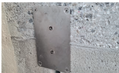
5. Fertig montierter Montageflansch
