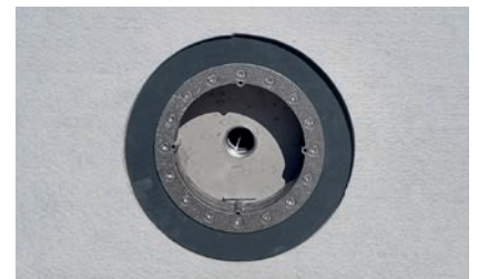
4. Grundelement gesetzt und bereit für Folienverlegung
