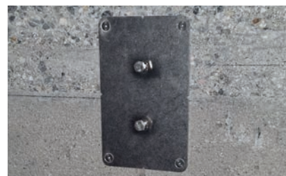
6. Zum Schutz der Sacklöcher Schraube eindrehen
