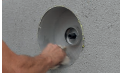
1. Gehäuse reinigen
