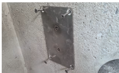
4. Montageflansch mit Schrauben und Dübeln montieren
