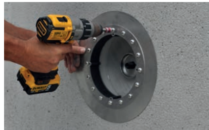
3. Grundelement anziehen, erst montieren, wenn Wände reprofiliert sind
