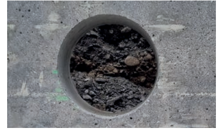
1. Kernbohrung \varnothing 250 mm
