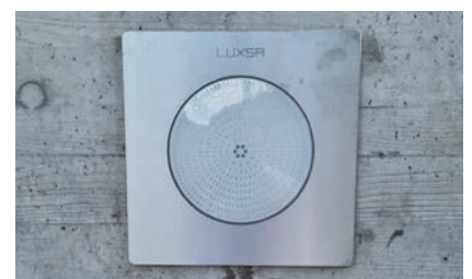
6. Fertig installierter Scheinwerfer
