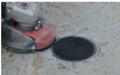
3. Leichtes Gefälle schleifen
