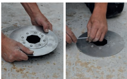
5. Grundelement setzen und mit Schlüssel anziehen
