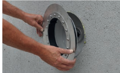
2. Grundelement setzen und ausrichten
