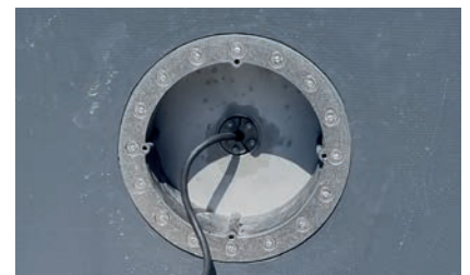
5. Kabel eingezogen und mit Press & Close-System abgedichtet
